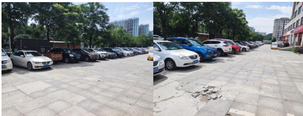
图 4- 19 咸宁绿洲湾停车场充电站
