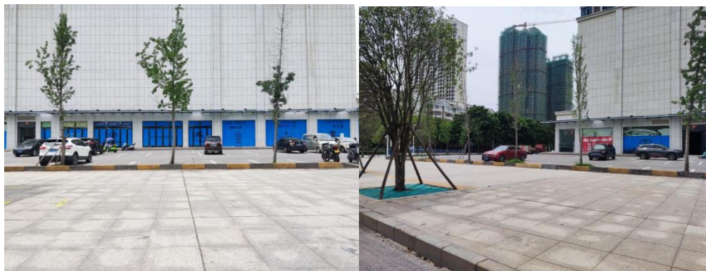
图 4- 41 银泉广场充电站
