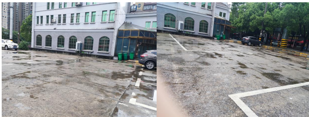
图 4- 44 三毛烧烤美食广场停车场充电站
