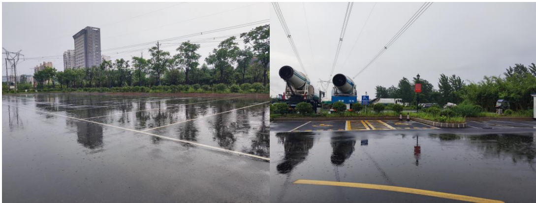
图 4- 4 肖桥货运停车场充电站
