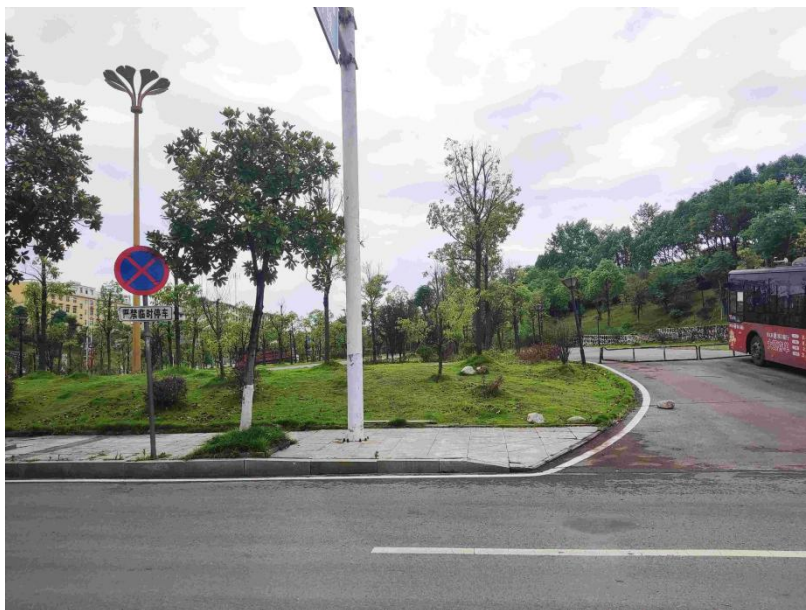
图 4- 56 赤壁高铁广场充电站
