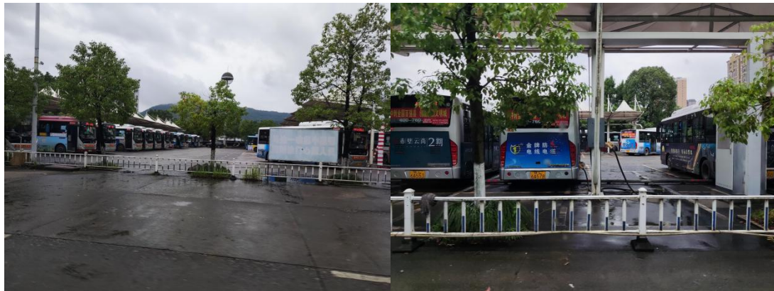
图 2- 10 赤壁市公交集团（火车客运站）充电站
