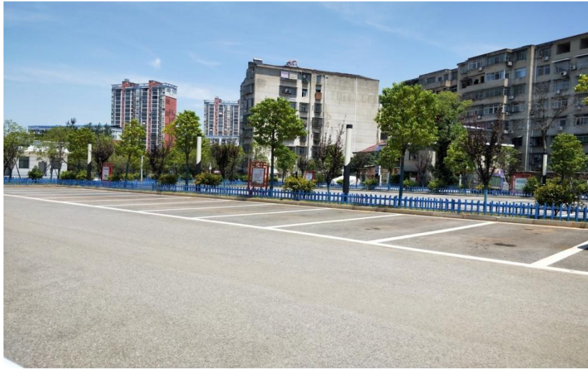
图 4- 75 城投停车场充电站
