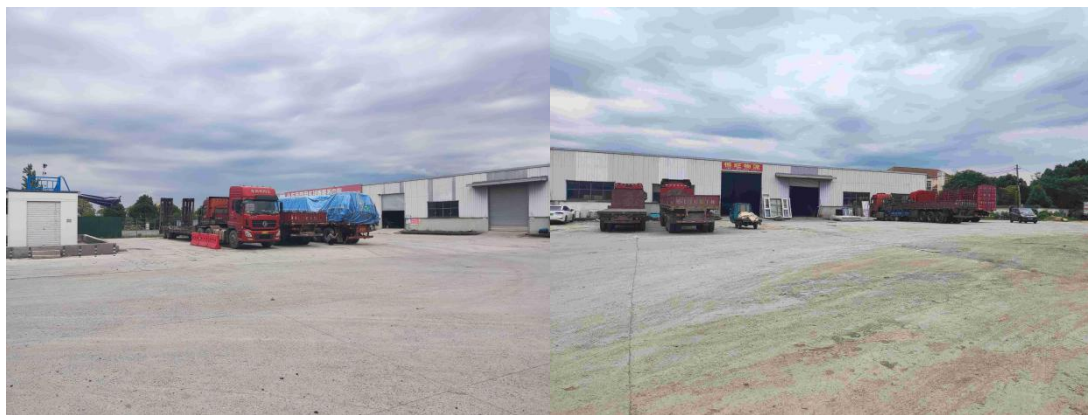
图 4- 5 咸宁汇宁物流充电站
