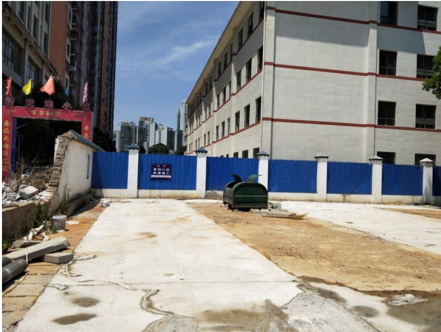
图 4- 78 新天地小区后门充电站
