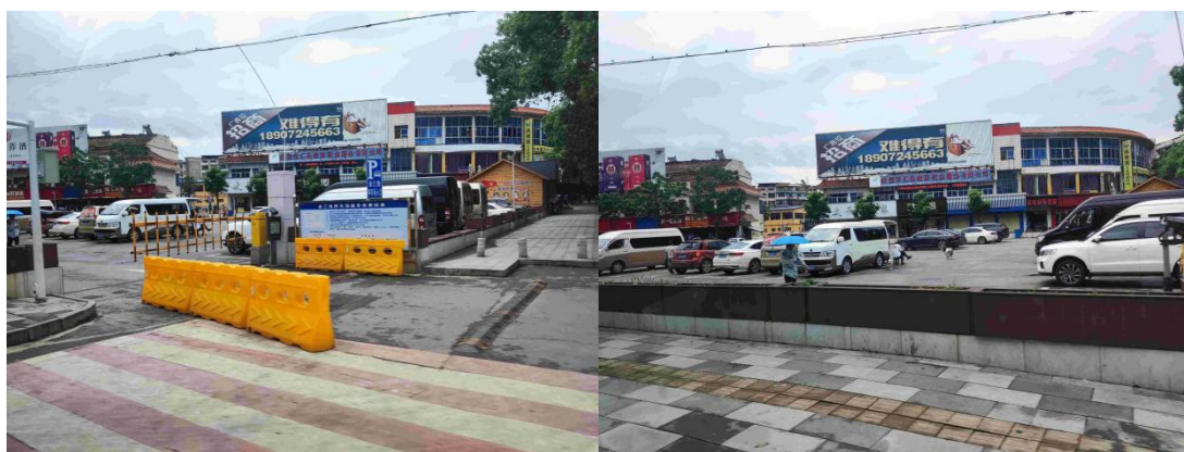
图 4- 65 金三角停车场充电站
