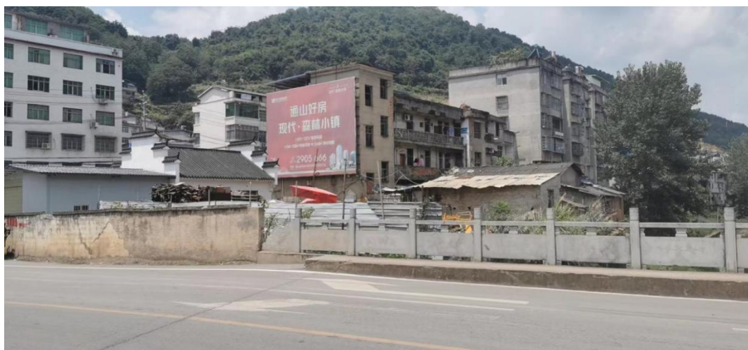
图 4- 112 通山县唐家地中桥充电站
