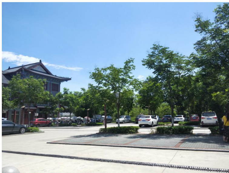
图 4- 86 通城县雁塔广场充电站
