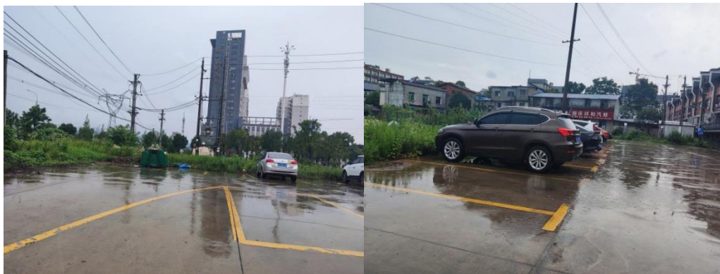
图 4- 21 咸宁市香城古街停车场充电站
