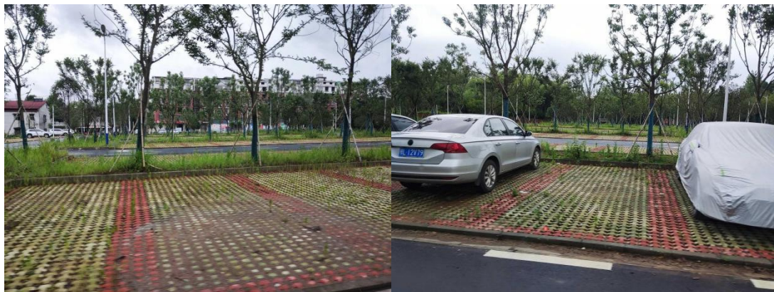
图 4- 55 中伙铺停车场充电站
