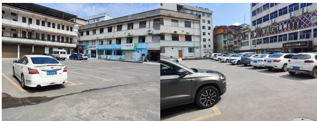
图 4- 33 城隍庙购物广场充电站
