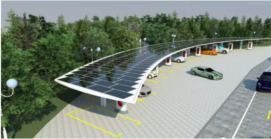
图 3- 6 光储充一体化充电站
