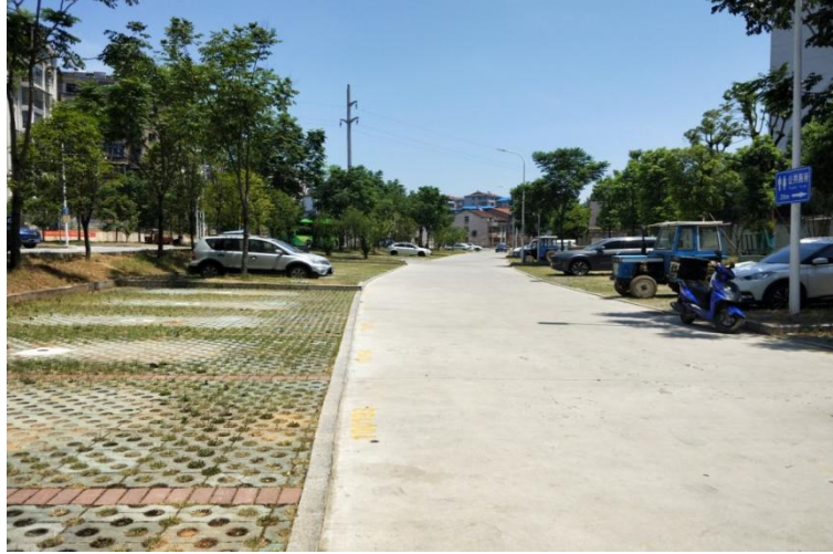
图 4- 77 木屐岭停车场充电站
